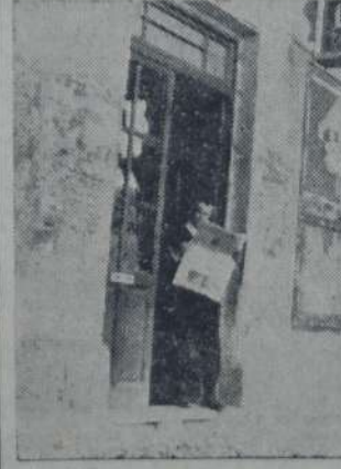
FRENTE DE LA PROPIEDAD ADQUIRIDA PARA LEVANTAR LA futura Casa del Pueblo.
